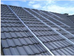
Bei der eingelegten Variante oder bei der Variante mit Kreuzverbund sind zuerst die senkrechten Schienen zu montieren. Benutzen Sie hierzu dieselben Schienen und Schrauben, wie bei der aufgelegten Variante beschrieben.
