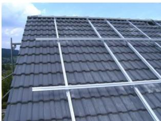
Für die eingelegte Variante muß die Schiene PVS5 als waagerechte verwendet werden. Der Abstand der Schienen errechnet sich aus der Modulhöhe + 2 mm.
