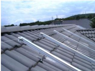
Um nun die waagerechten Schienen montieren zu können, müssen die Riffelwinkel PVRW1 montiert werden. Verwenden Sie zum Ausrichten eine Richtschnur. Zum Befestigen nutzen Sie die Hammerkopfschrauben M 8 x 20 PVHKS820 mit den Flanschmuttern M 8 mit Sperrverzahnung PVFM8. Die Riffelung an den Winkeln erleichtern es Ihnen, die waagerechte Schiene eben in der Höhe auszurichten.
