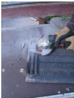
Flexen Sie von der oberen Dachpfanne die Dichtlippen über dem Dachhakenbügel passend weg, damit sie wieder dicht auf der unteren aufliegt.
