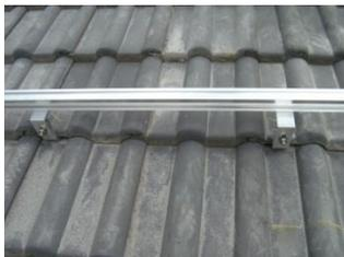
Bei der aufgelegten Variante montieren Sie bitte die Schienen PVS2 waagrecht auf die Dachhaken. Nutzen Sie dazu die Hammerkopfschrauben M 8 x 20 PVHKS820 und die Flanschmutter M 8 mit Sperrverzahnung PVFM8.
