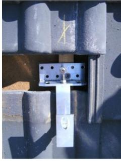
Platzieren Sie den Dachhaken, richten Sie ihn aus, benutzen Sie zum fixieren zwei Tellerkopfschrauben PVTKSxxx (verfügbare Längen 80 / 100 / 120 mm).
